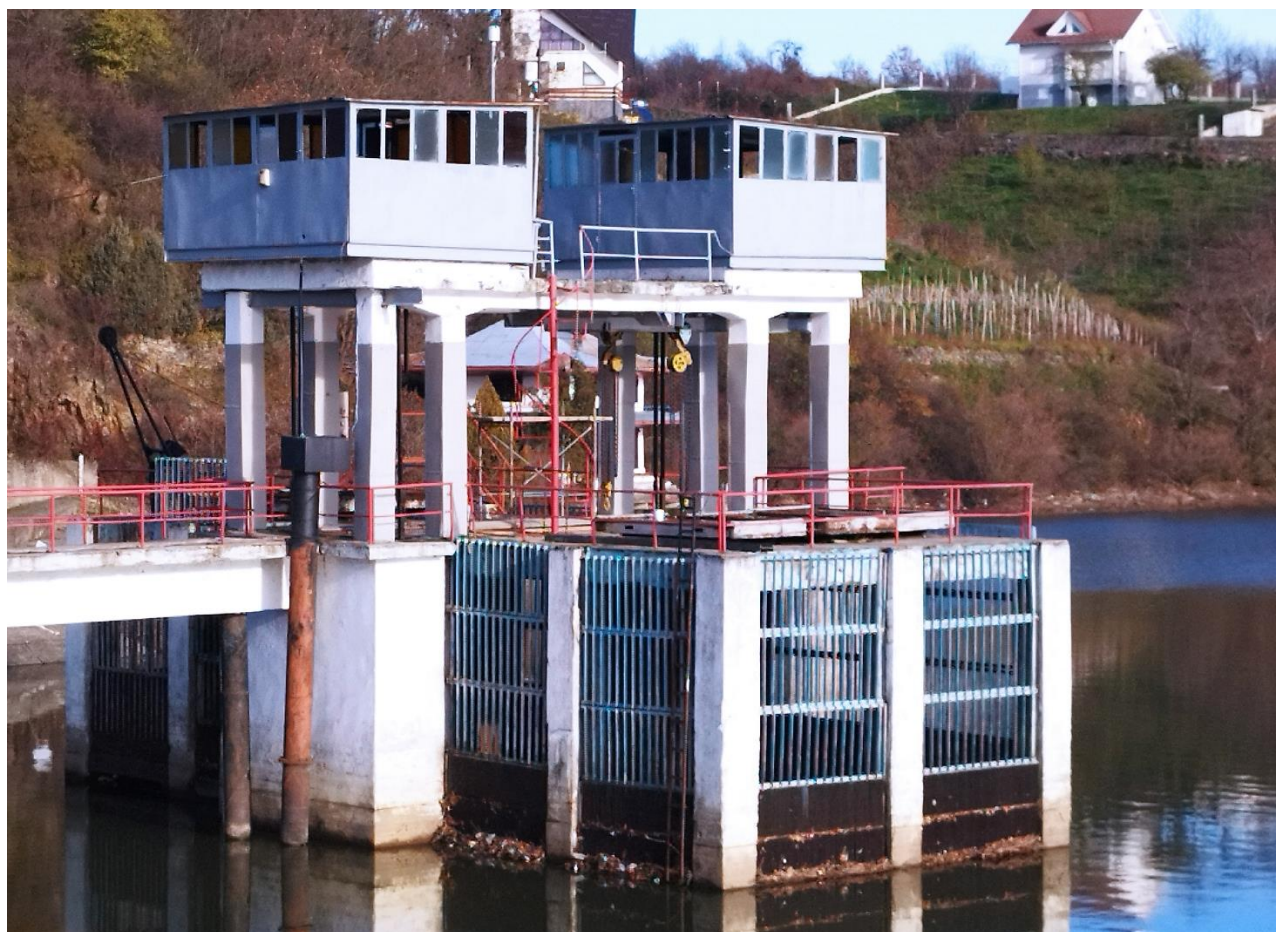
Barajul de la Calinești-Oaș (clădire tehnică)
